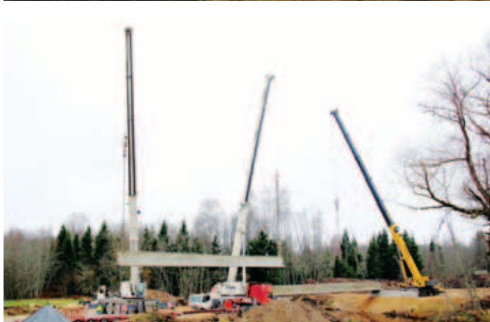
Talad tõsteti paika kolme kraanaga, andes tala õhus kraanalt kraanale edasi.
