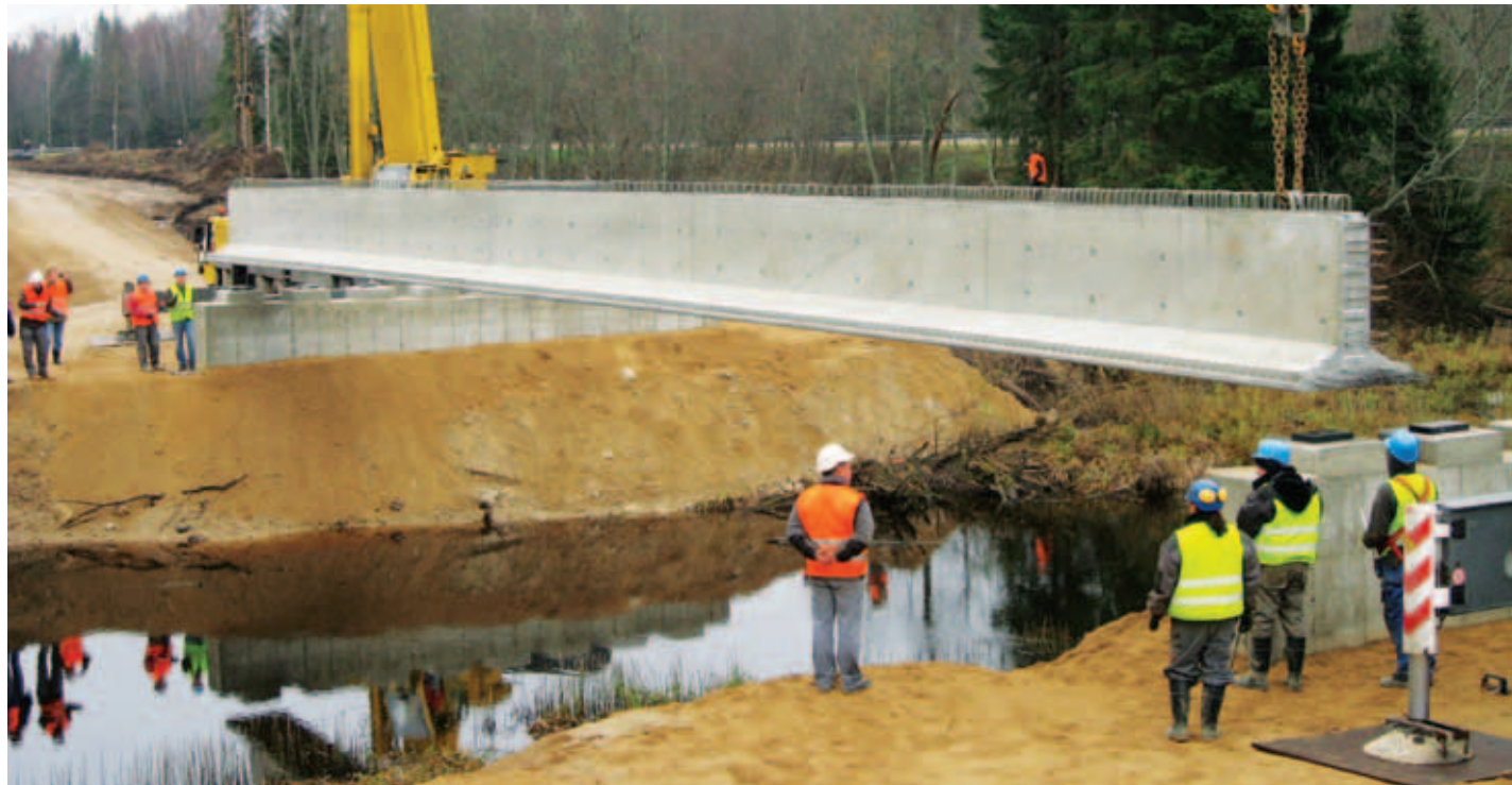
Urva silla talade montaaž 1. novembril 2011. Tala pikkus on ligi 30 meetrit ning mass 42 tonni.
